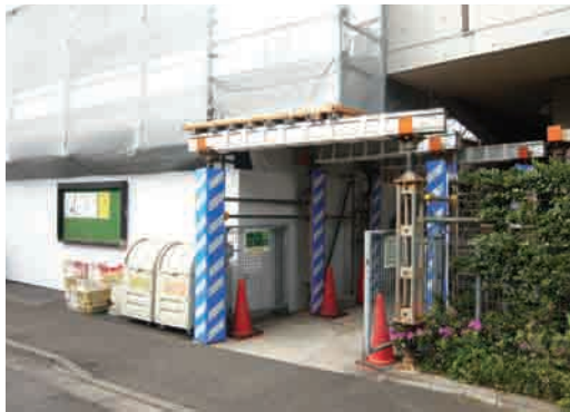
工事の様子を見ながら 通り抜けした仮の玄関
